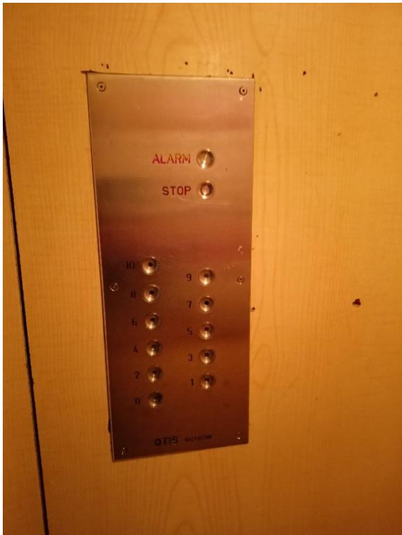
Stan wewnętrzny istniejącej windy.
