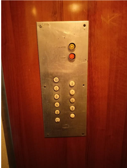
Stan wewnętrzny istniejącej windy.
