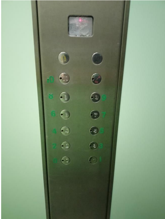
Stan wewnętrzny istniejącej windy.
